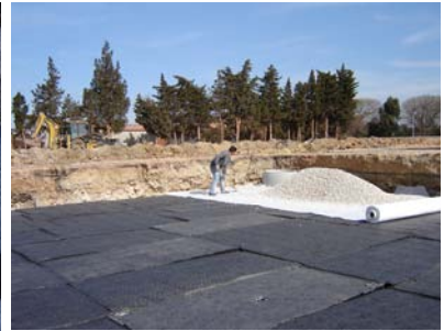
Mise en œuvre du remblai initial sur géotextile (couche de ventilation)
