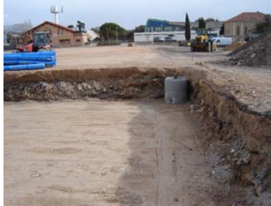
Préparation du fond de forme
