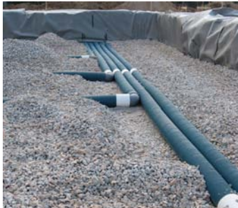
Mise en place du réseau de drains de diffusion/évacuation
