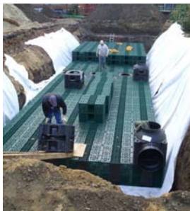
Mise en œuvre et assemblage des SAUL sur géotextile (2)
