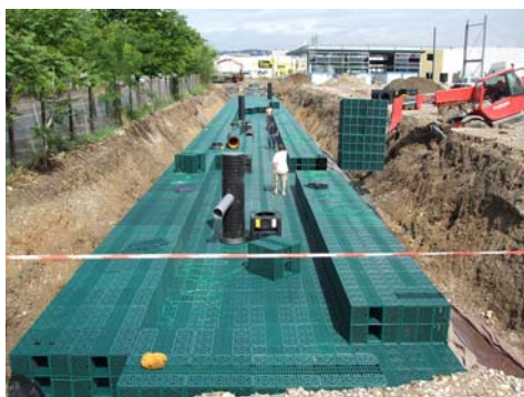
Photo 5.3 : Exemple de mise en œuvre de deux couches de SAUL
