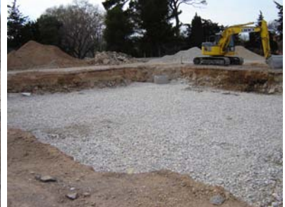
Mise en œuvre de la couche de diffusion
