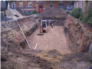
Terrassement et nivellement du fond de forme
