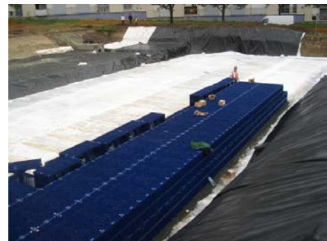
Photo 5.1 : Exemple de mise en œuvre de SAUL
