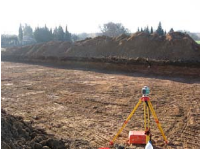
Terrassement et nivellement du fond de fouille
