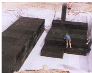
Photo 2.2 : Mise en œuvre de SAUL en nid d'abeilles
