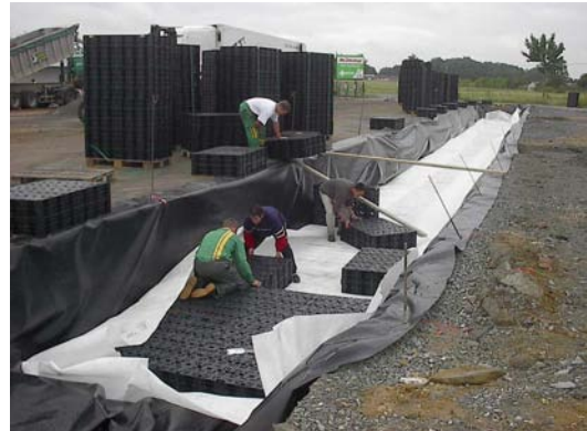
Photo 3.9 : Pose de modules de SAUL sur une geomembrane protégée par un géotextile
