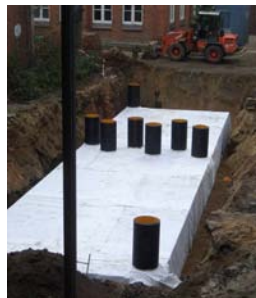
Recouvrement par le géotextile et mise en place de tampons ventilés
