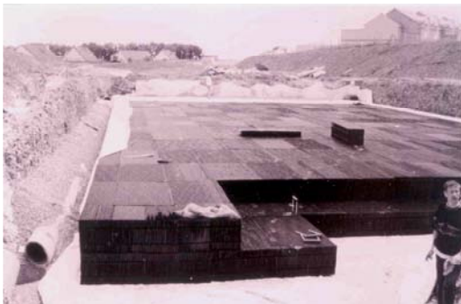
Photo 2.5 : Réalisation d'un bassin enterré...
