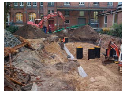
Mise en œuvre des remblais latéral, initial et supérieur
