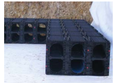
Photo 3.4 : Exemple de SAUL à canal de diffusion
