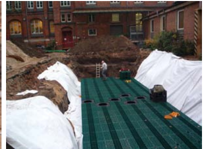
Mise en œuvre et assemblage des SAUL sur géotextile (1)
