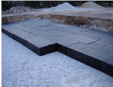
Mise en œuvre des SAUL (en rangs croisés ici)
