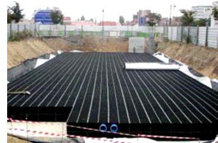
Photo 3.3 : Exemple de SAUL à diffuseur interne
