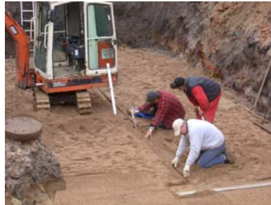
Préparation du lit de pose
