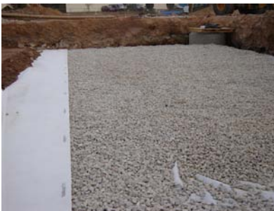
Achèvement du remblai initial
