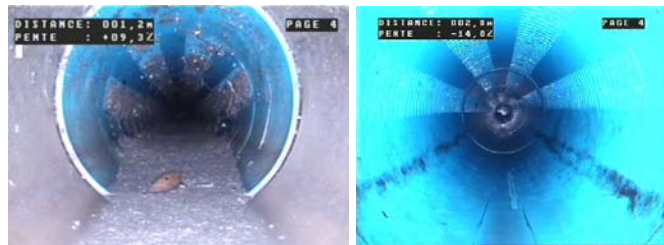
Photo 2.11 : Exemple de canal de diffusion avant et après hydro curage
