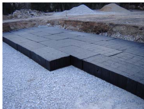
Photo 5.4 : Exemple de mise en œuvre de SAUL homogène à joint croisé
