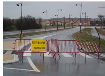
Photo 1.2 : Voirie submergée par des eaux de ruissellement
