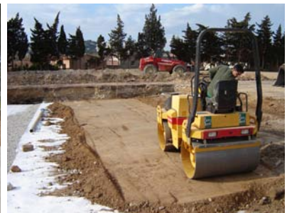
Compactage du remblai supérieur
