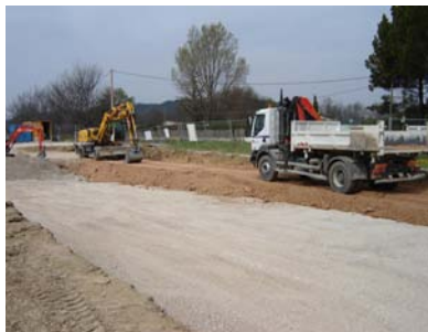
Mise en œuvre du remblai supérieur
