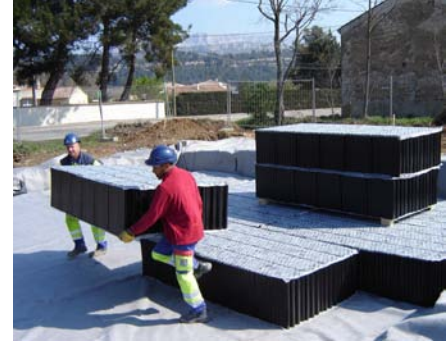
Photo 2.4 : Une mise en œuvre aisée et rapide
